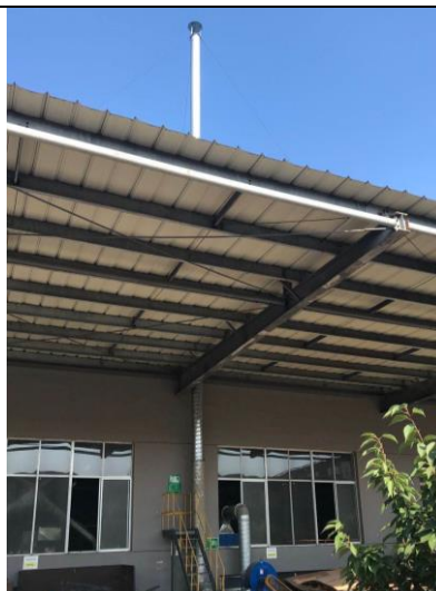
等离子切割机配套滤筒除尘器及排气筒
